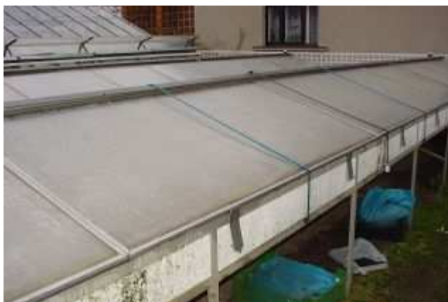
Zimní izolace boků polystyrenem
